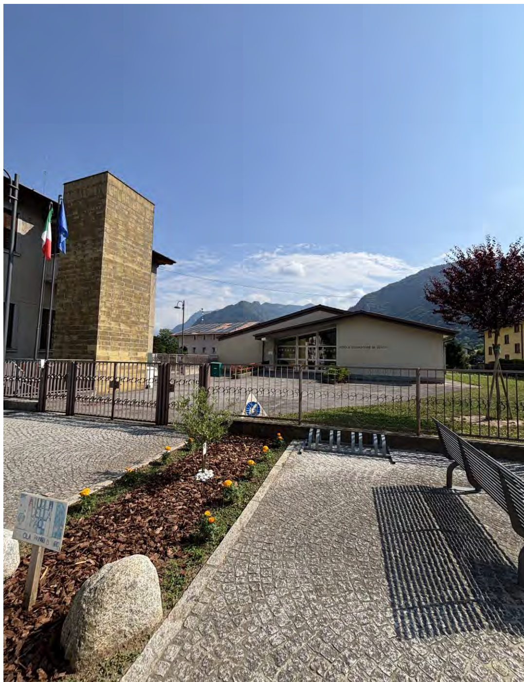
Vista dell'ingresso della scuola primaria da Via Cadoniano
